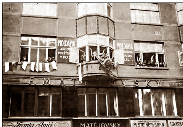
Odstraňování císařského orla 28. října 1918 z fasády
